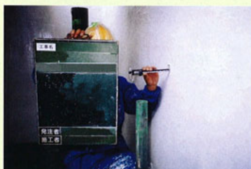
5 ライニング膜厚検査工
