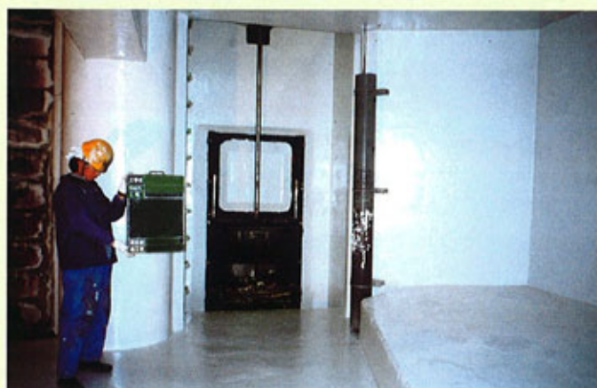
6 ライニング工 完了
